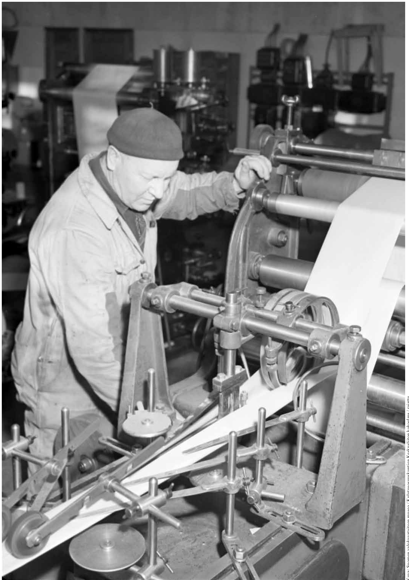
Tehtaan työntekijä valvoo paperipusseja tekevää konetta.
